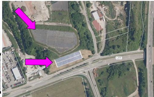
Abb. 4-6: Orthophoto mit realisierten Anlagen
