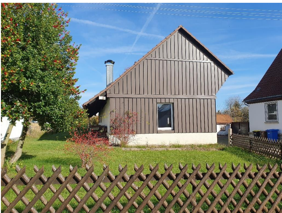
Abb. 3: ausgebauter Schuppen mit gepflegtem Garten auf Flst. 2826
