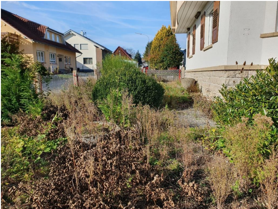
Abb. 4: Wohnhaus mit Brachfläche auf Flst. 2826
